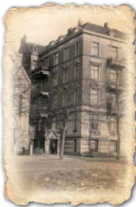
1950 - No terceiro andar desta construção na rua Finkenau, nr 5, em Hamburg, morava a Família Rudolph
